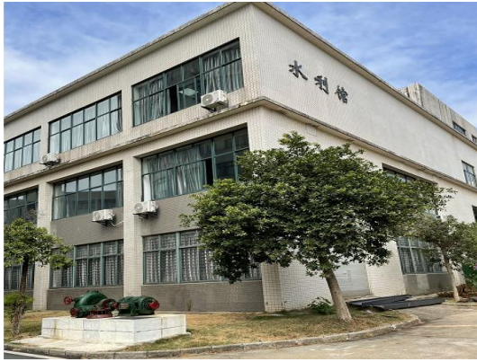
图1 水利实验中心外墙
